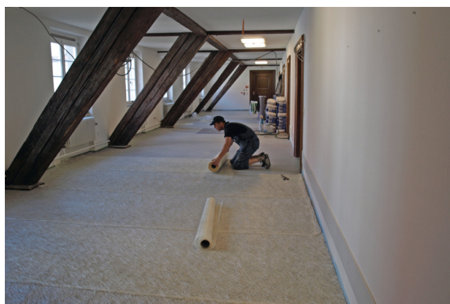
Τοποθετήστε το UZIN RR 201 σε όλη την επιφάνεια που πρόκειται να ανακαινιστεί.
