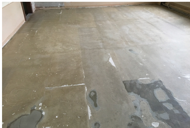
Υφιστάμενο υπόστρωμα που χρειάζεται ανακαίνιση
