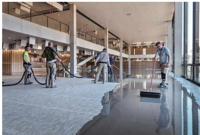
Αντλήστε το ισοπεδωτικό κονίαμα UZIN NC 160 πάνω από το UZIN RR 201.
